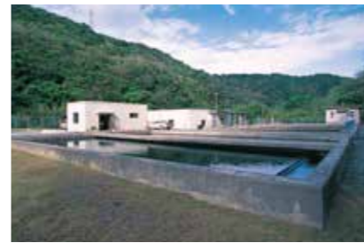
大宜味村津波浄水場
