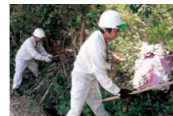
林道に不法投棄されたゴミの撤去作業
