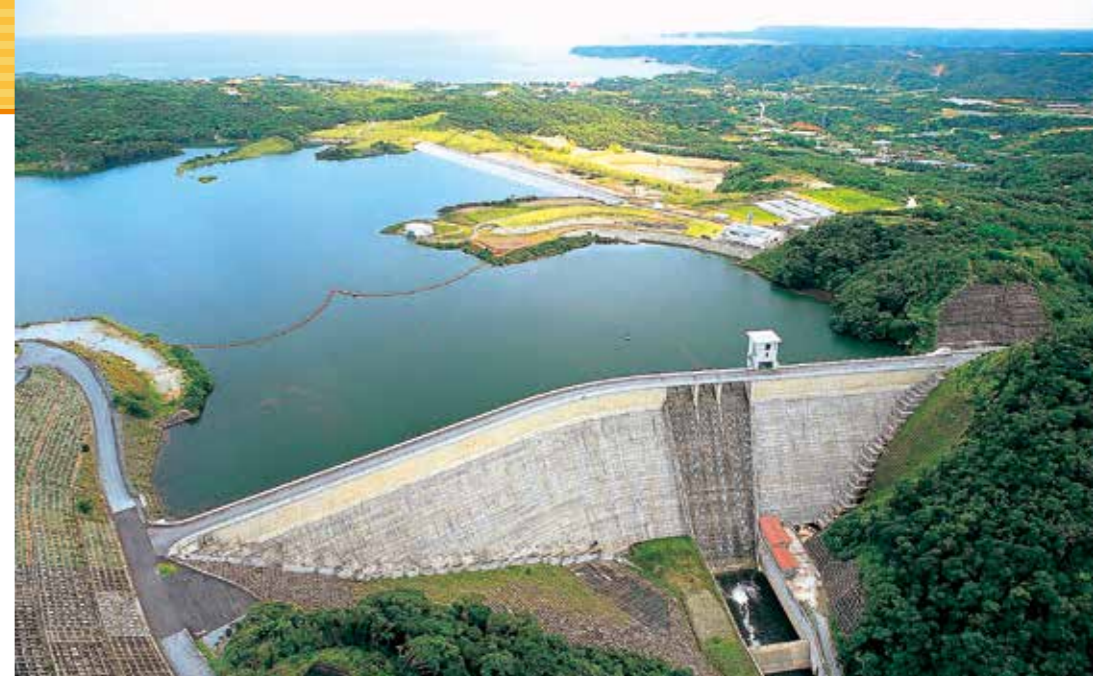
周辺の環境に配慮しながら建設された大保ダム。建設時の土砂は結の浜の埋立てに利用されました。
