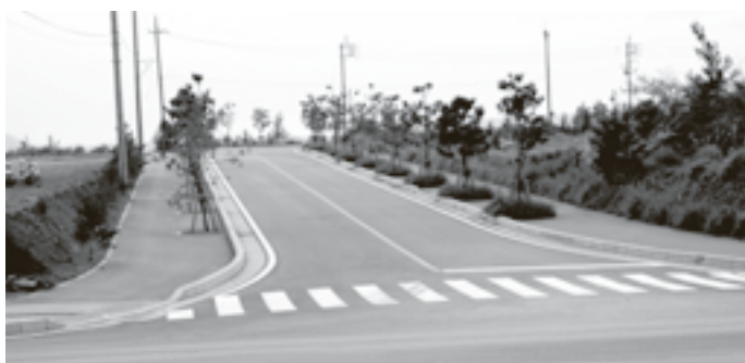
一部供用が開始された村道結の浜線
