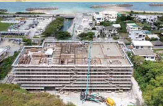
新庁舎建設の様子
