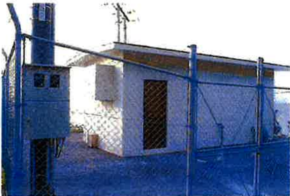
上原増圧ポンプ場
