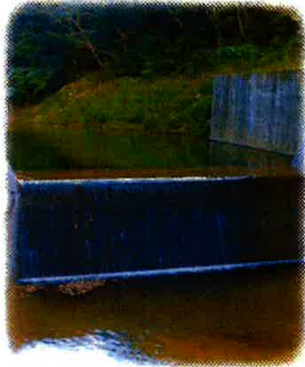
平南川支流の取水堰
