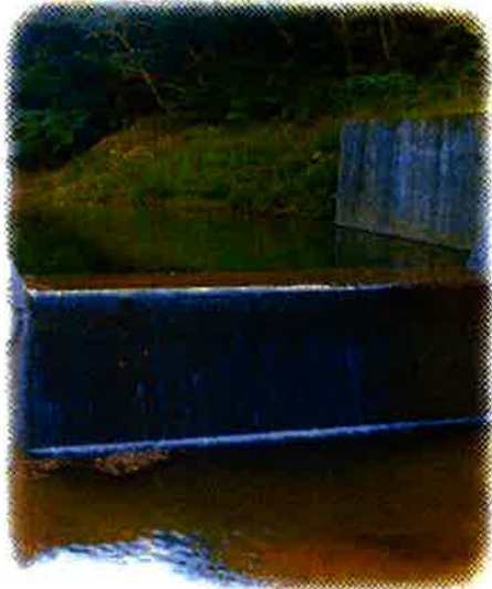
平南川支流の取水堰
