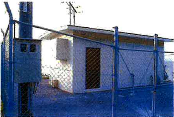
上原増圧ポンプ場
