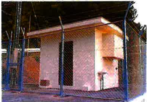
謝名城増圧ポンプ場
