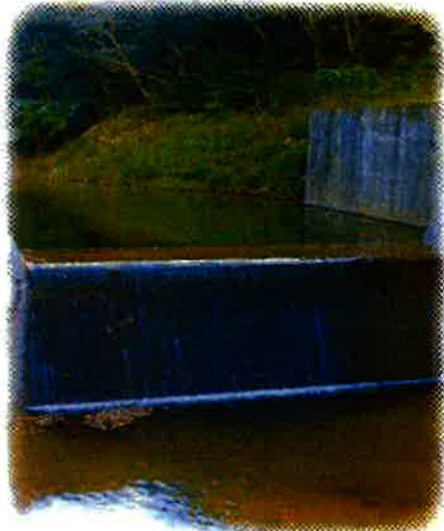
平南川支流の取水堰
