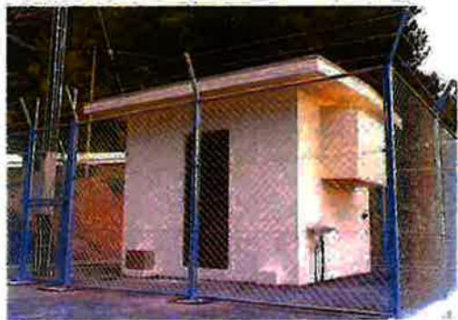
謝名城増圧ポンプ場
