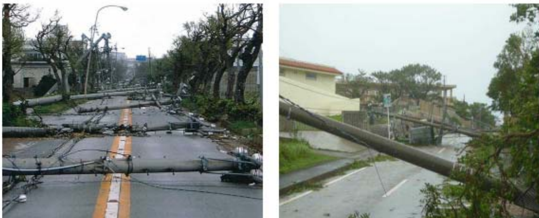
写真－1 台風による電柱倒壊状況
