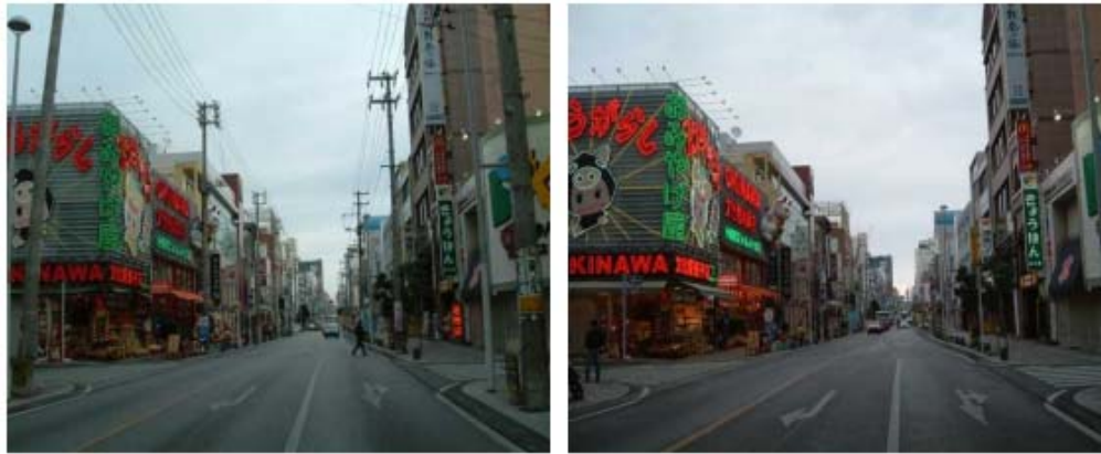
写真－2 国際通り(那覇市)の整備前後の状況(左:整備前、右:整備後]
