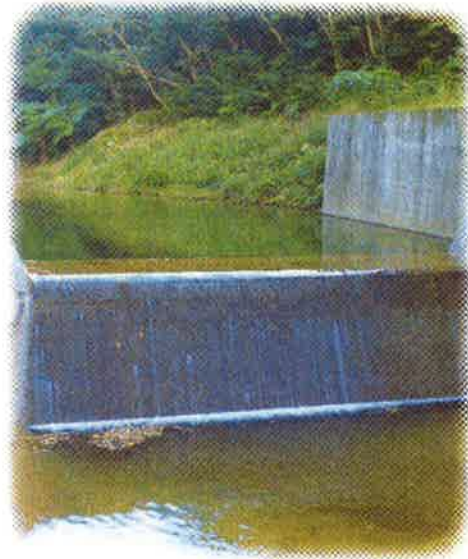
平南川支流の取水堰
