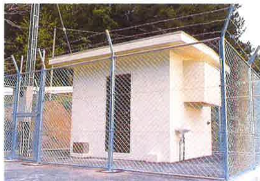
謝名城増圧ポンプ場
