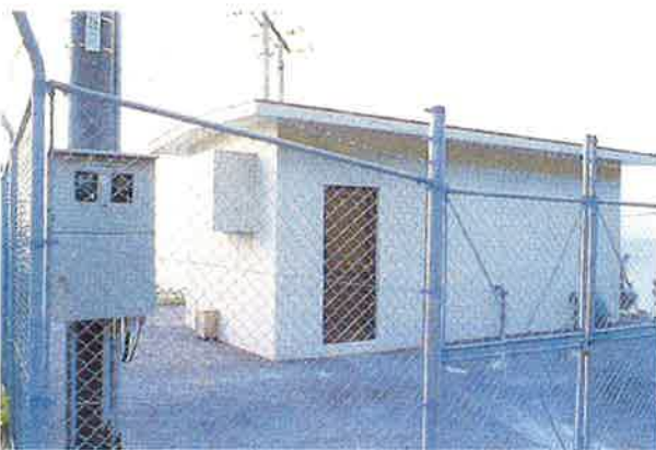
上原増圧ポンプ場
