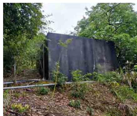
▲左：謝名城の簡易水道施設。奥に濾過タンクがある ▲右：濾過設備のあるタンク
