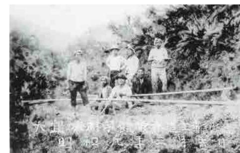
▲饒波水道工事記念 昭和9年（饒波誌）
