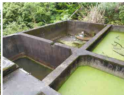
▲左：謝名城の簡易水道施設。奥に濾過タンクがある ▲右：濾過設備のあるタンク
