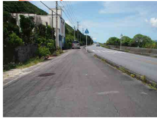
▲根路銘 国道58号沿い 南向け 2022年7月
