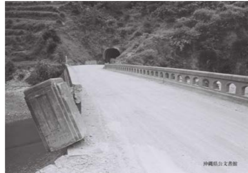
▲大国トンネル（日米援助工事 1964/6/12）
