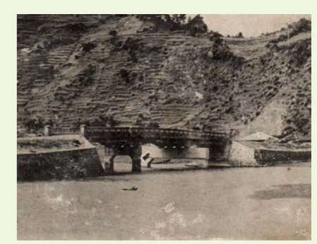
▲昭和9年完成の大保橋
