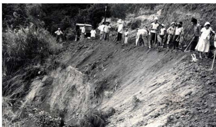
押川村道崩落修復作業
