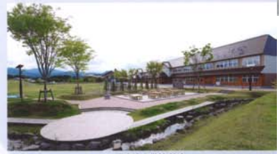
西会津小学校 校舎
