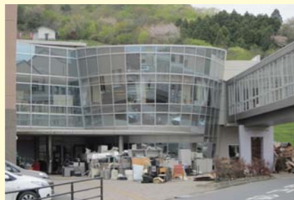
◆町立病院横の福祉避難所2階（1階津波の被害を受け使用不能）
