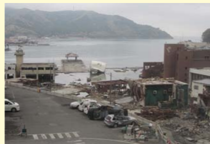
◆福祉避難所正面港風景（周辺の建物4階まで津波の被害を受ける）
