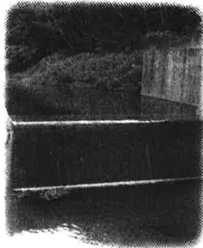
平南川支流の取水堰
