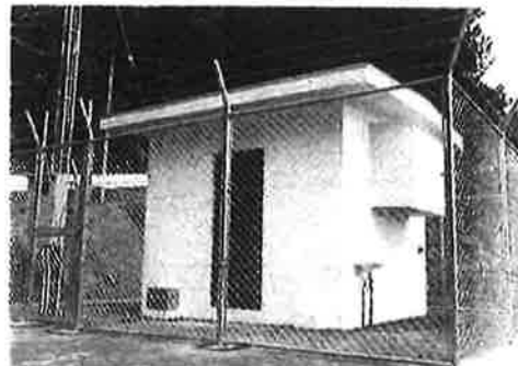
謝名城増圧ポンプ場
