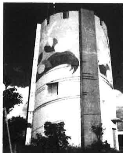
江洲高架配水池
