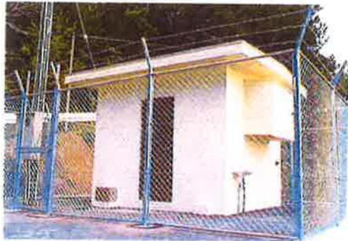
謝名城増圧ポンプ場
