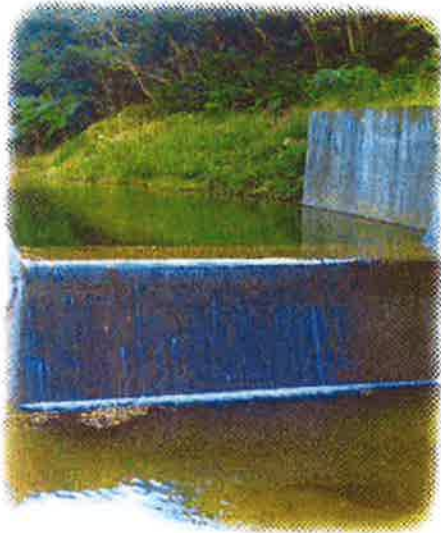
平南川支流の取水堰
