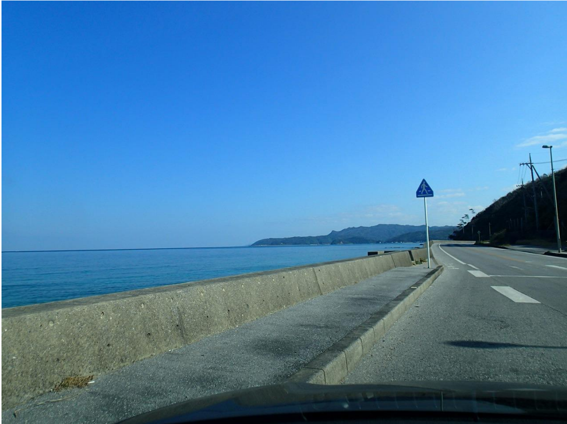
図 2.1-10 St. Vからの車窓景観（源河川河口付近のバス停留所付近より）
