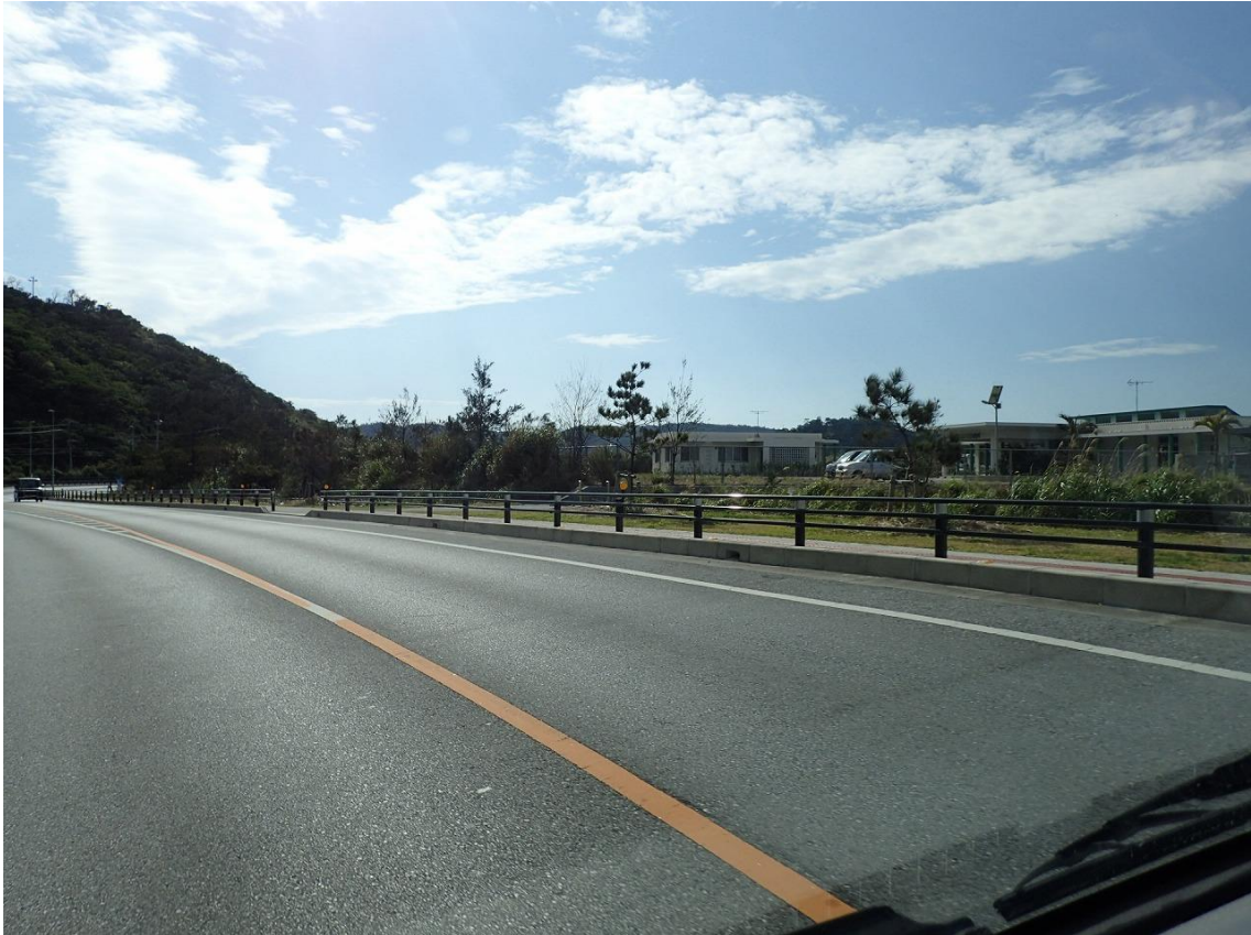
図 2.1-8 St. IIIからの車窓景観（結の浜南部のすぐ背後より）
