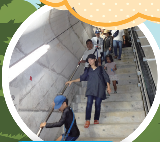
ダム堤内見学
