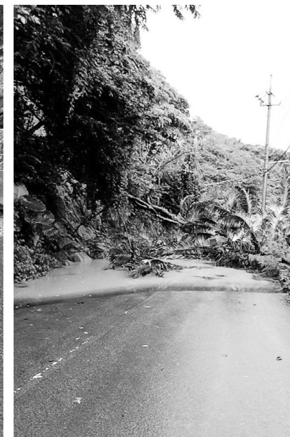
平南當原線土砂崩れ
