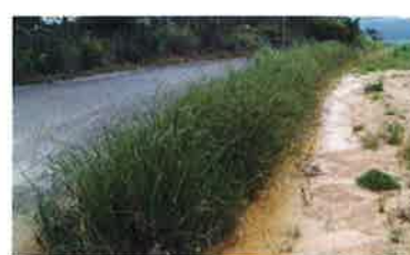
(グリーンベルト設置)
